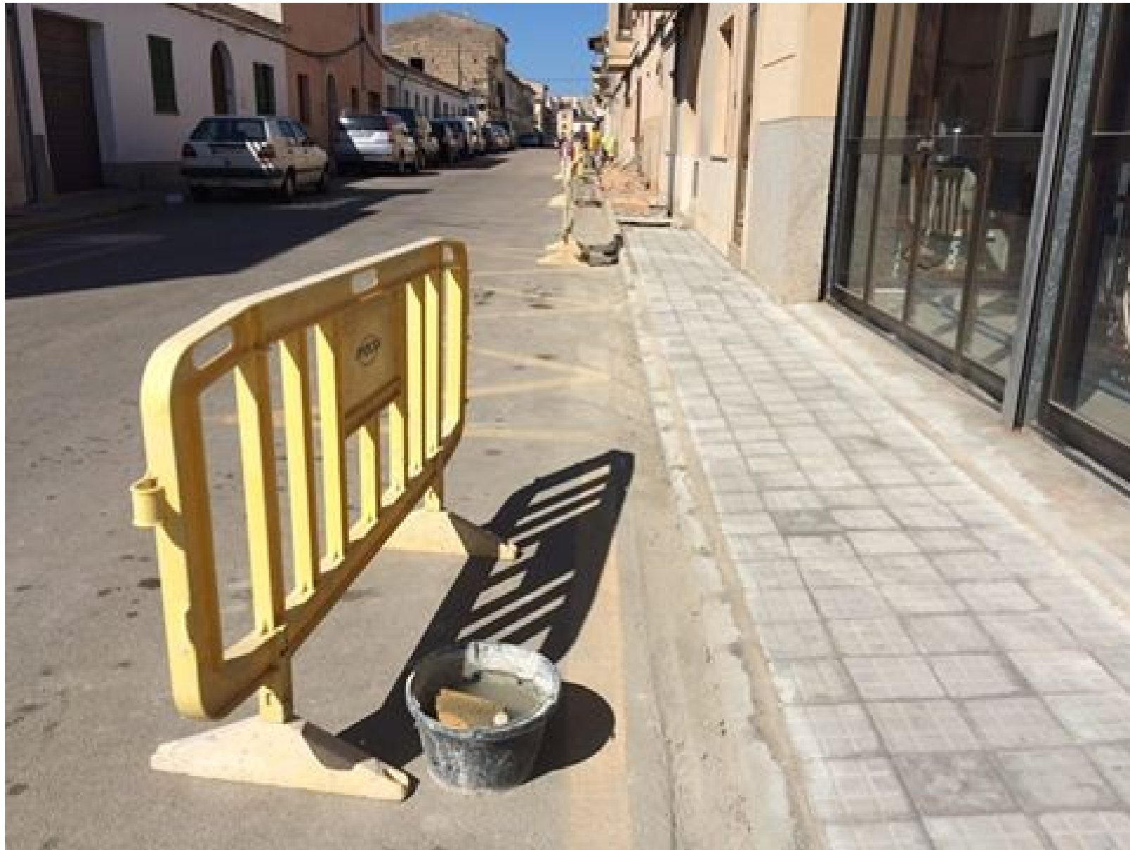
Obres al carrer Bartomeu Pou
